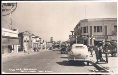
330 AVE. GUERRERO, NUEVO LAREDO, TAMPA, MEXICO.
